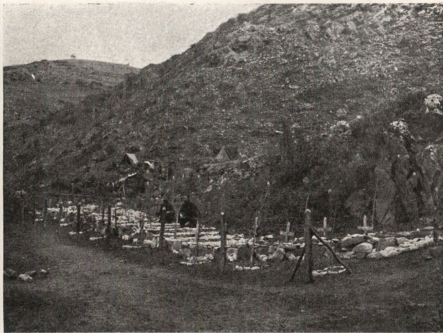
Гробље на положају Беле Воде 7. и 8. пука (бр. 1). Groblje na položaju Bele Vode 7. i 8. puka (br. 1).
